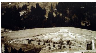
Fort Airolo Nordfassade
